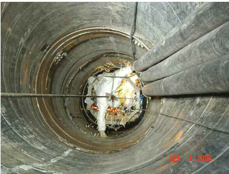
Abbildung 1: Sanierung eines eingedrückt PEHD-Schachtes mittels Stahlhülsen
